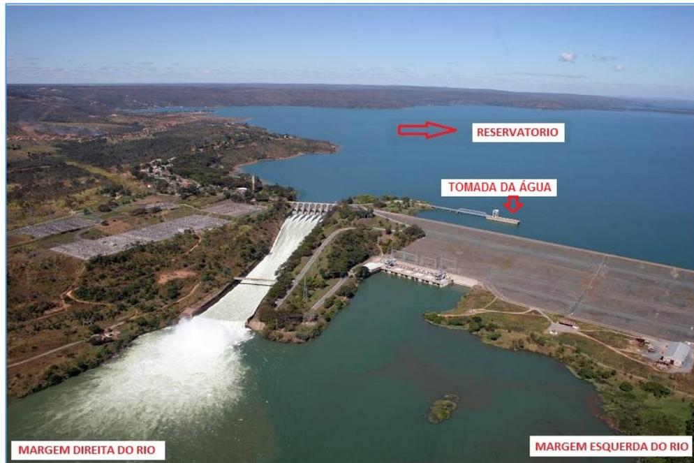
Fonte: CEMIG, 2012. (Imagem modificada pela autora, identificação dos componentes da Usina Hidrelétrica).
