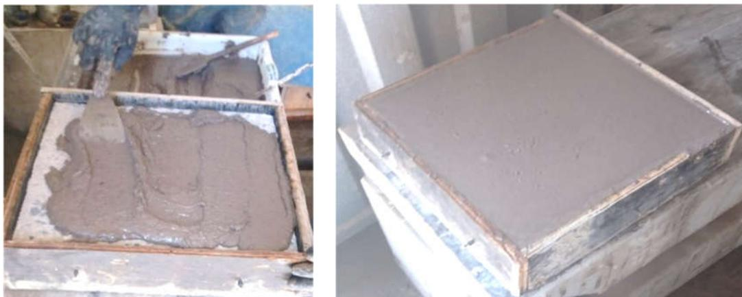
**Figura 15** - Aplicação da argamassa de reparo no substrato de concreto.
