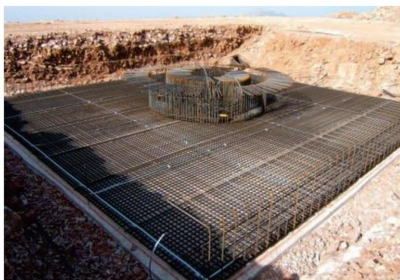
Figura 2.14 Fundação retangular de uma turbina eólica – retirado de [40].
