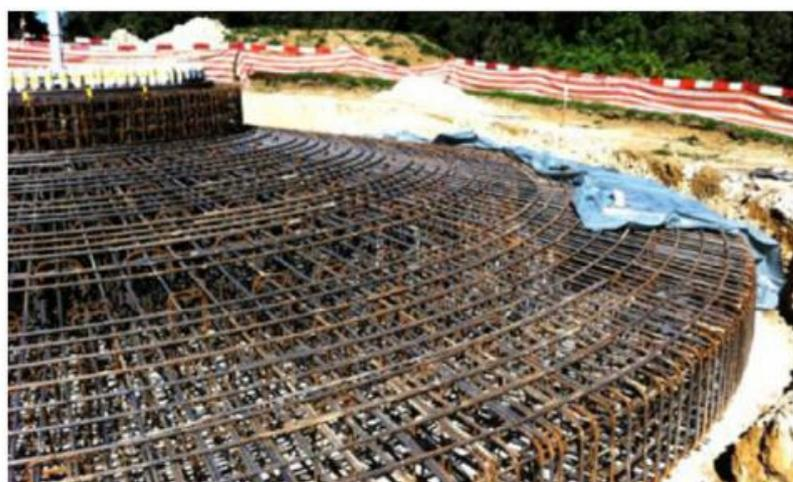
Figura 2.15 Fundação circular de uma turbina eólica- retirado de [41].
