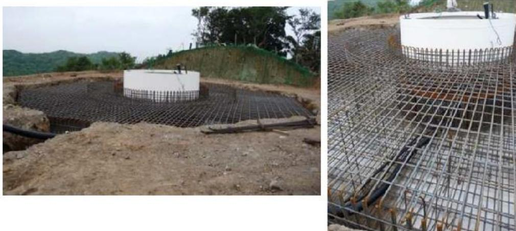
Figura 2.13 Fundação octogonal de uma turbina eólica – retirado de [39].
