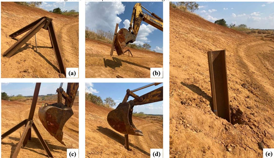
a) Centralizador do sistema de ancoragem b) Içamento da ponteira de ancoragem c) Posicionamento e centralização da ponteira d) Cravação da ponteira no solo; e) Ponteira finalizada aguardando cabo de aço.
