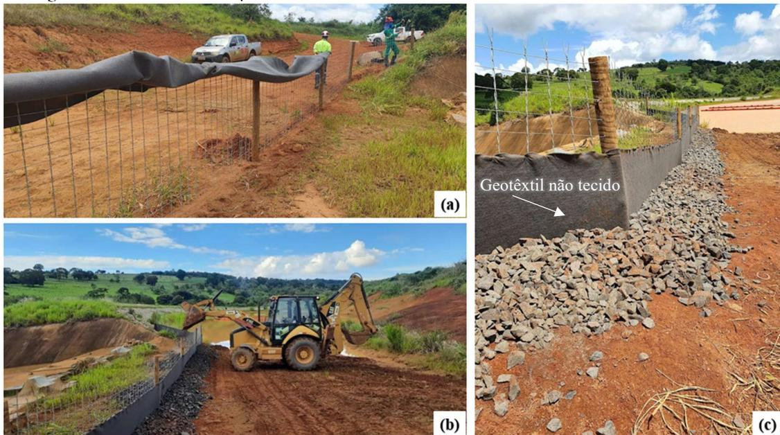
a) Amarração da malha trançada de arame galvanizado; b) Posicionamento do enrocamento; c) Cortina de controle de sedimento finalizada.
