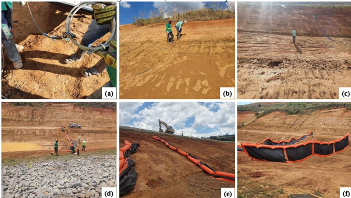
a) Amarração dos cabos de tensão; b) Fixação dos cabos de tensão na ancoragem; c) Posicionamento dos cabos de tensão ao longo do ponde; d) Posicionamento e amarração da cortina no cabo de tensão; e) Tensionamento do cabo de aço; f) Cortinas instaladas aguardando o enchimento do ponde.
