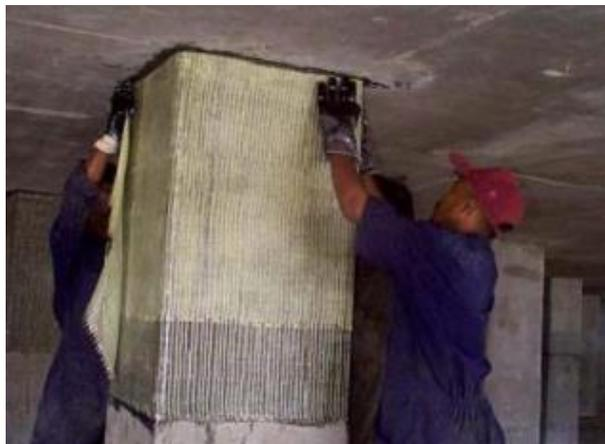
**Figura 3.9 – Fotografia da coluna revestida com PRF de vidro**
